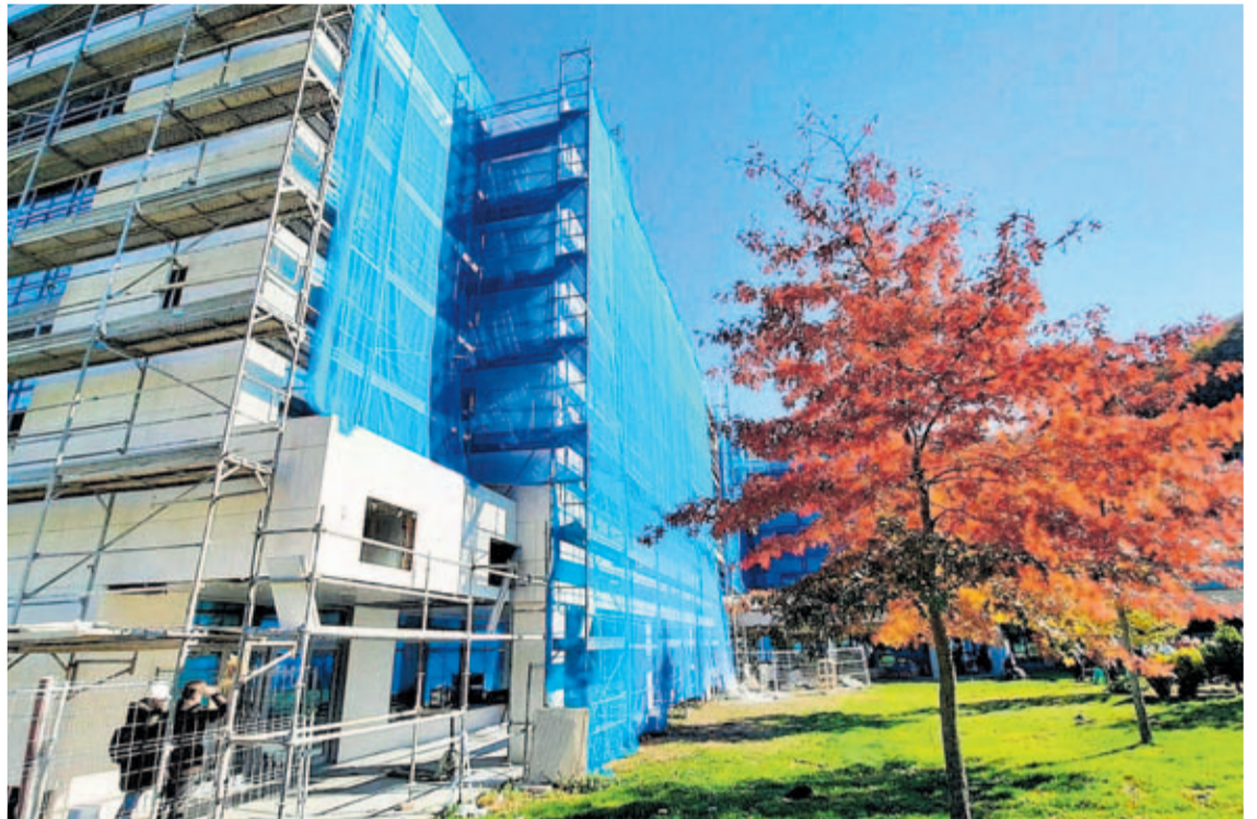
Las obras en la residencia de Felechosa.
