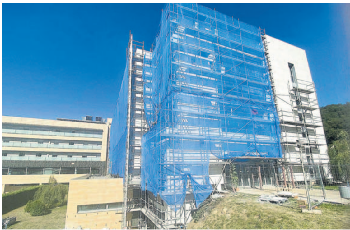
Obras en la residencia de mayores de Felechosa. | Vivas
